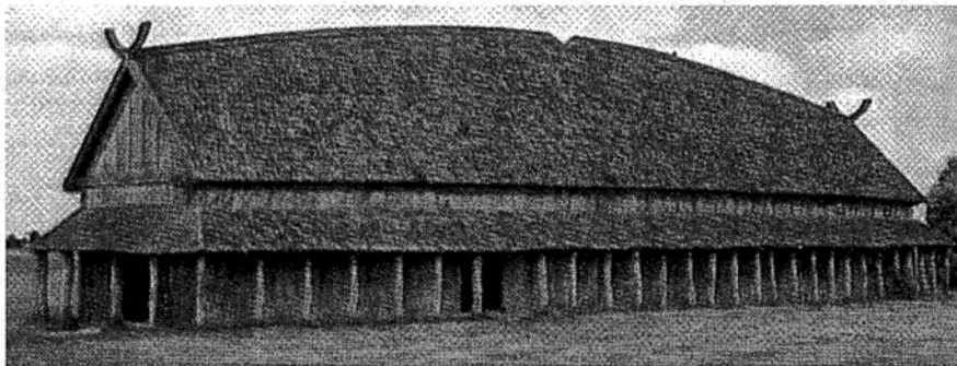
Trelleborg, Denmark: Viking House 1000-1050 A.D.
